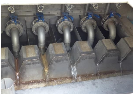
Regard sur les puits et le collecteur des sources
